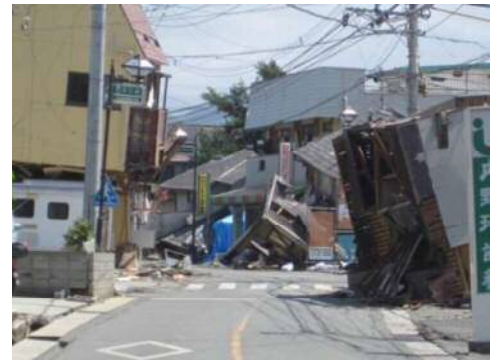
地震で損壊した建物
